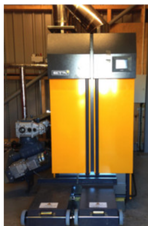
CN Seeds Eta Hack 200 (200kW-Pellet-boiler)
